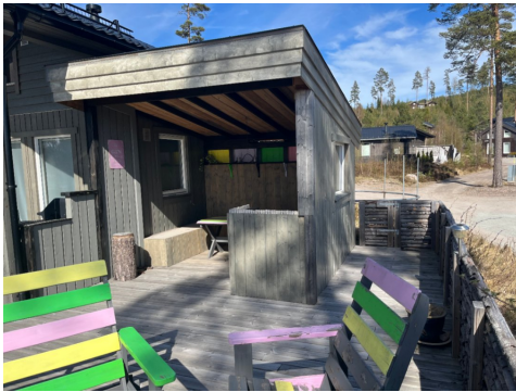
Tilbygg på terrasse.
