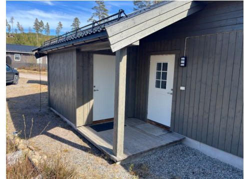
Bod ved inngangsparti.
