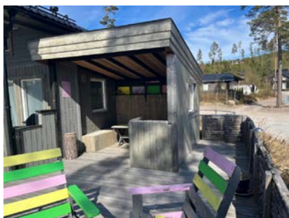
Tilbygg på terrasse.
