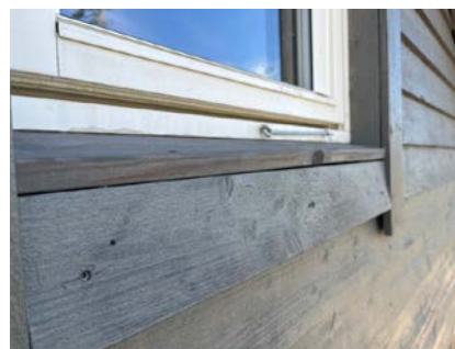
Det anbefales beslag på vannbrett under vindu.
