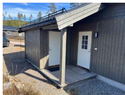
Bod ved inngangsparti.
