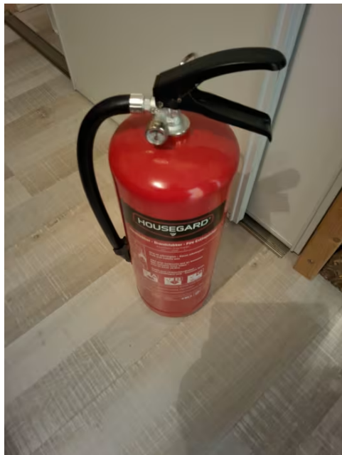
Brannslukningsapparatet er plassert på soverom.
