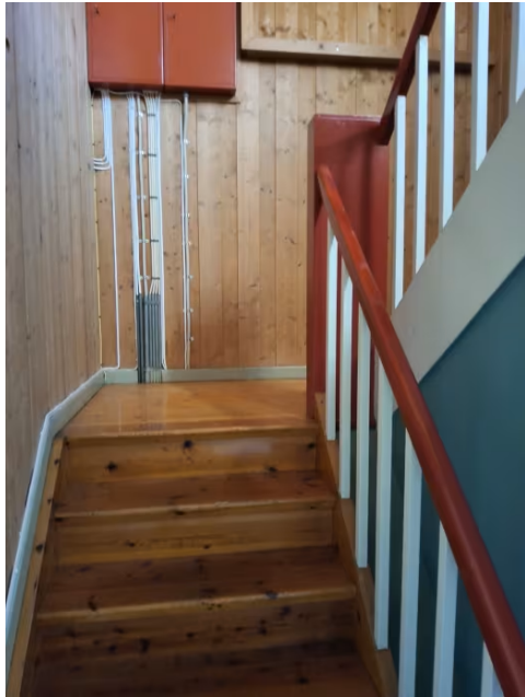
Trapp mellom 1. etasje og 2. etasje.
