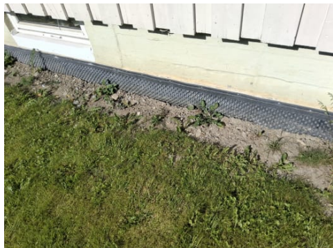
Det er etablert utvendig grunnmursplast.
