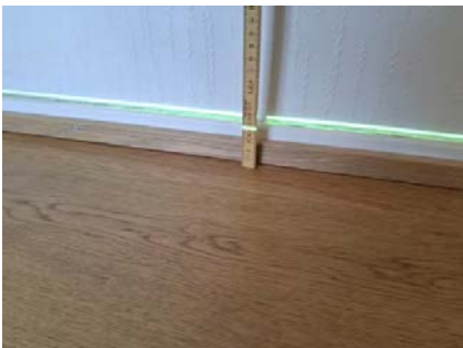
Etasjeskille er kontrollert med nivelleringslaser.
