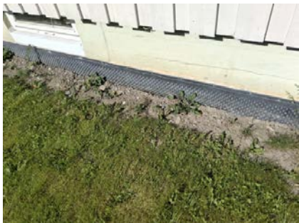
Det er etablert utvendig grunnmursplast.
