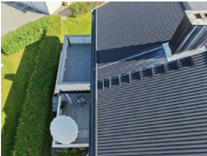
Det er etablert takstige og snøfanger.
