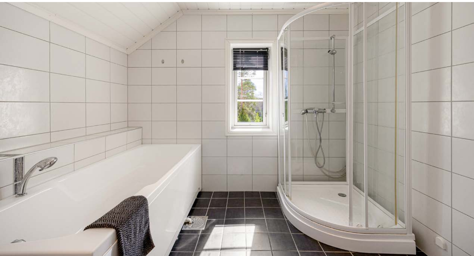
Badet er utstyrt med badekar, dusjkabinett, veggmontert toalett og balansert ventilasjon.
