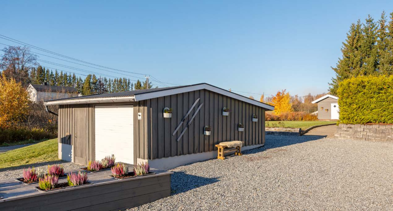
Det ble foretatt drenering i 2023/24.
