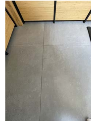
Flis i underetasje.
