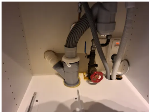
Leiligheten har synlige avløpsrør av plast.
