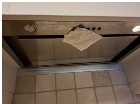
Avtrekkseffekten er testet med papir.
