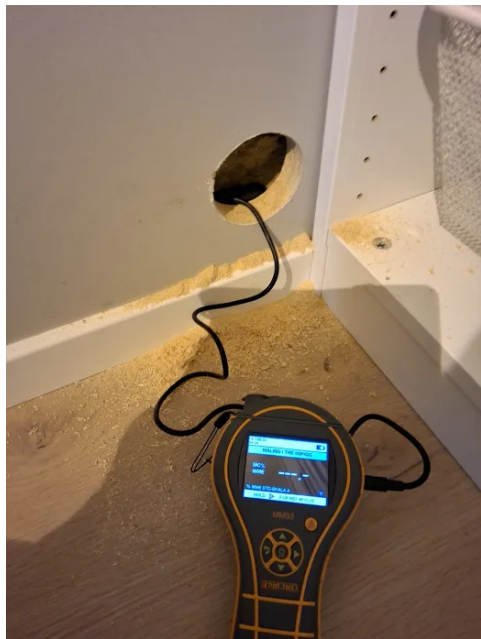
Bilde fra fuktmåling i veggkonstruksjon tilstøtende dusjsone.
