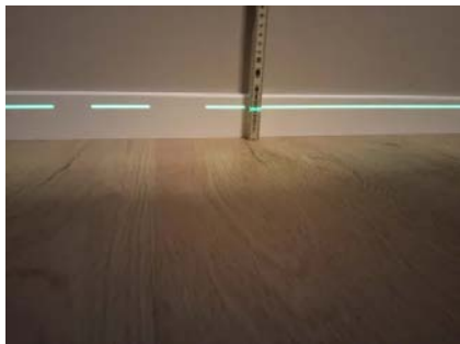
Etasjeskillet er kontrollert med nivelleringslaser.
