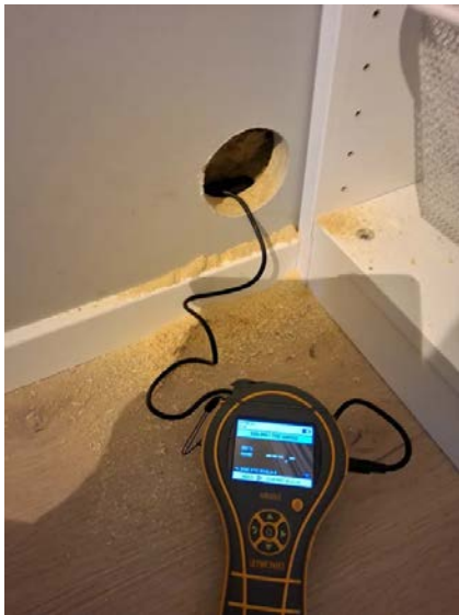
Bilde fra fuktmåling i veggkonstruksjon tilstøtende dusjsone.
