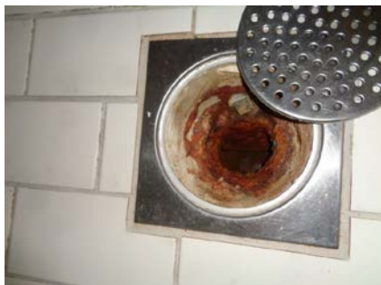
Støpejernsluk i dusjsone.
