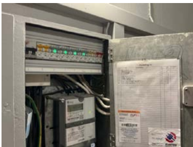
Automatsikringer i sikringskap plassert i gang/fellesareal.
