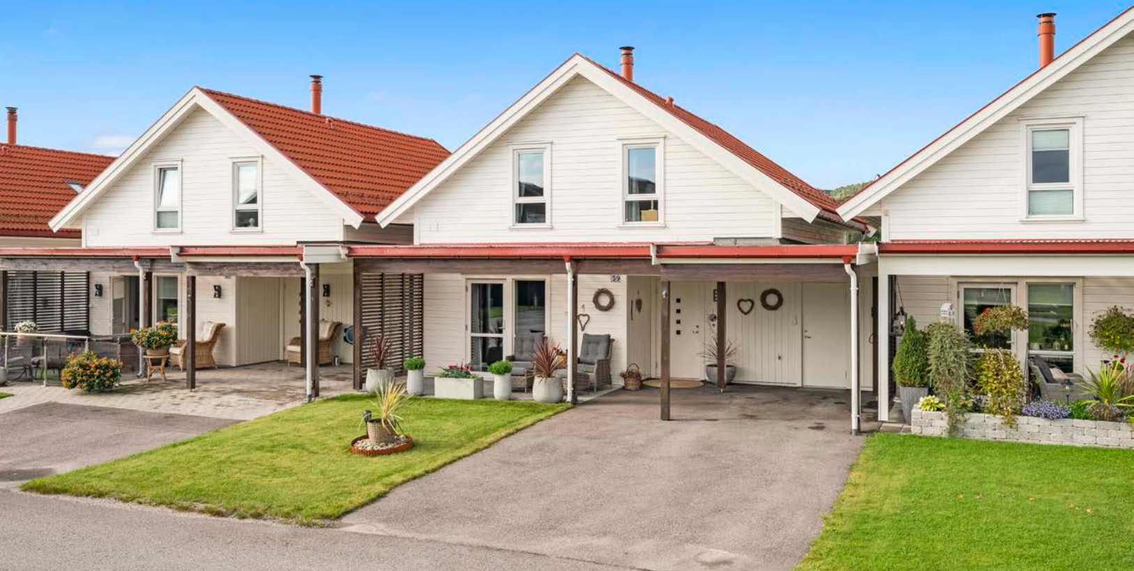
Asfaltert gårdsplass og overbygget inngangsparti med uteplass. Carport med elbillader
