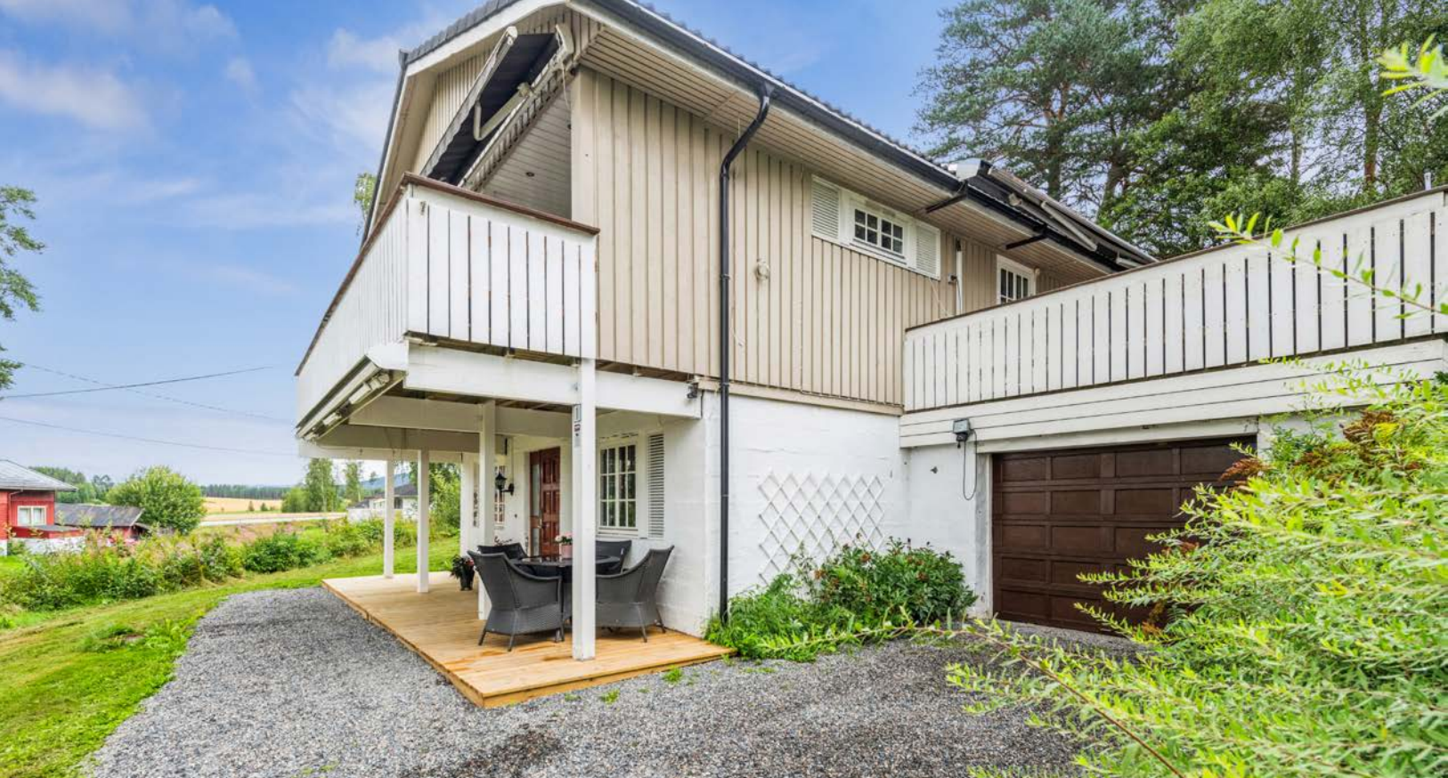
Det er en parkeringsplass i garasje i underetasjen av boligen og egen gårdsplass.
