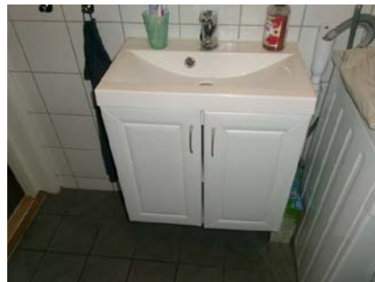
Innredning med vask.
