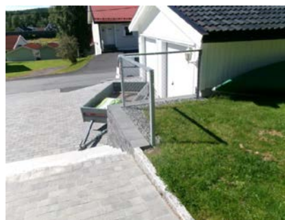
Støtte mur av blokker
