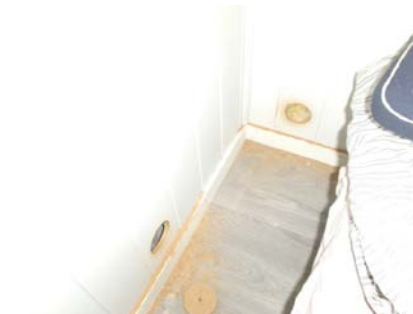
Hulltaking i yttervegg og vegg tilstøtende bad.
