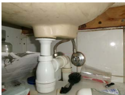
Avløpsrør til vask uten synlige lekkasjer.
