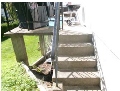
Betong trapp til terreng
