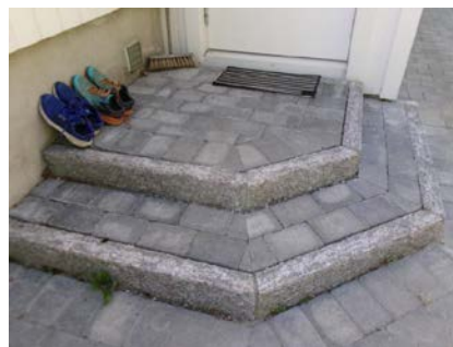
Trapp til inngangsdør 1.etg.
