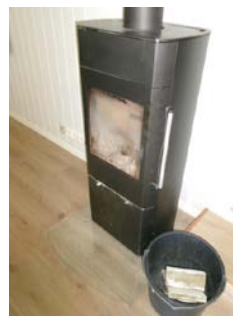
Vedovn med glassdør i underetasjen fra år 2022
