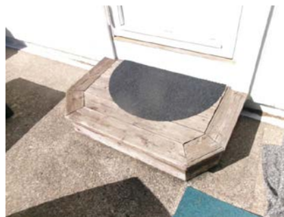
Trapp til terrasse 1.etg.
