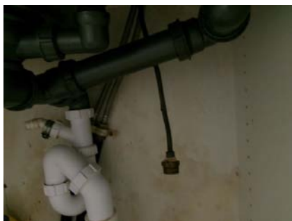
Vann og avløp uten synlige lekkasjer.
