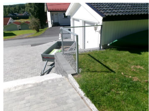
Støtte mur av blokker
