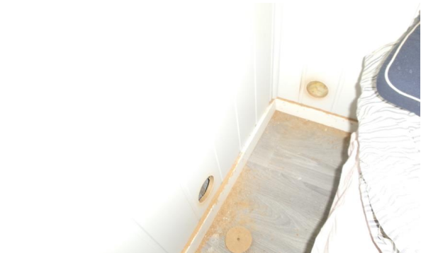
Hulltaking i yttervegg og vegg tilstøtende bad.
