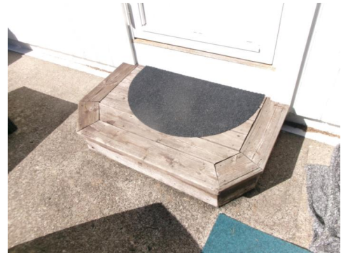
Trapp til terrasse 1.etg.
