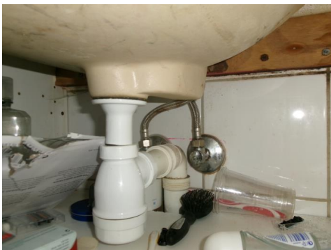
Avløpsrør til vask uten synlige lekkasjer.
