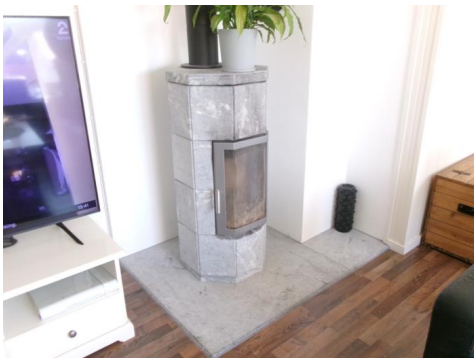
Vedovn med glassdør i 1.etg fra år 2023.
