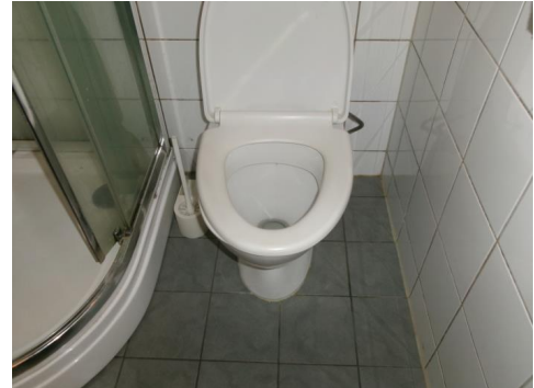
Dusjkabinett og wc
