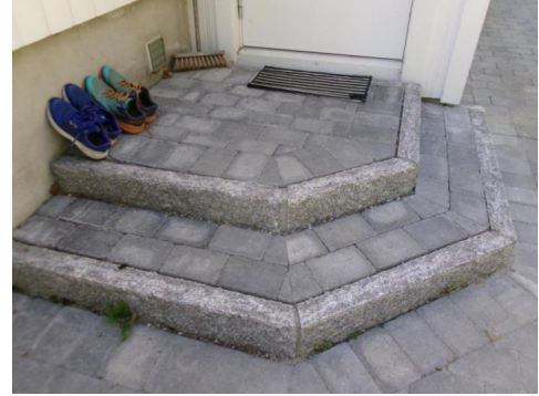
Trapp til inngangsdør 1.etg.
