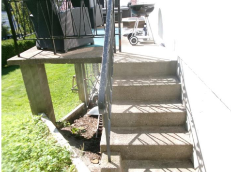
Betong trapp til terreng
