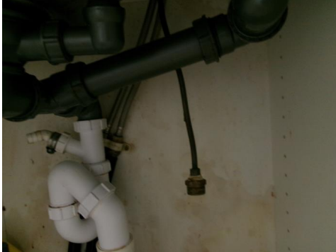
Vann og avløp uten synlige lekkasjer.
