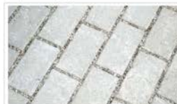
Permeabelt dekke med beleggingsten
