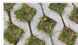
Permeabelt dekke med gresspaver
