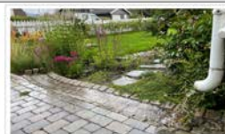
Referansefoto: Takvann ledes i renne vekk fra bygget og ned regnbett.
