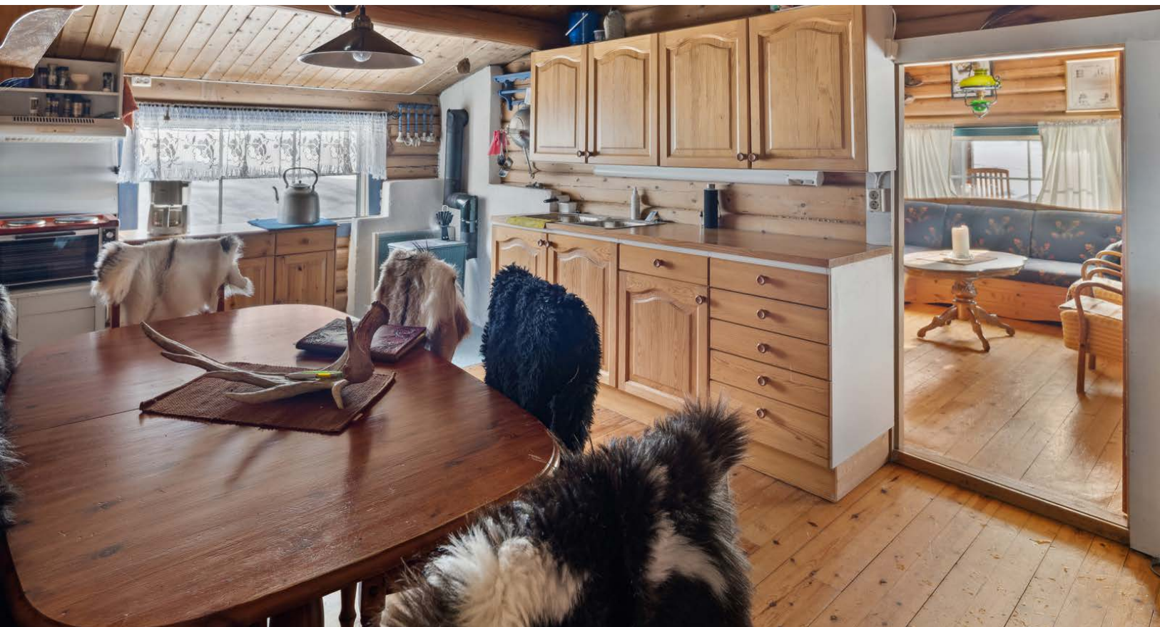
Kjøkkeninnredning med over- og underskap i tre med speil fronter og heltre benkeplate med to rustfrie kummer. Gråvann føres ut i terreng.
