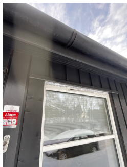
Montere lister over vindusventiler der dette mangler
