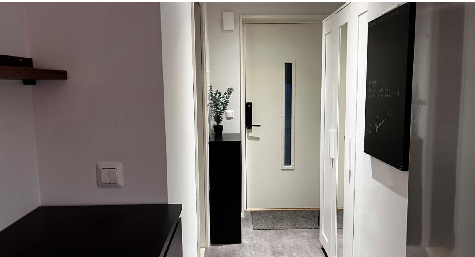
Det er belegg på gulv og downlights i himling.
