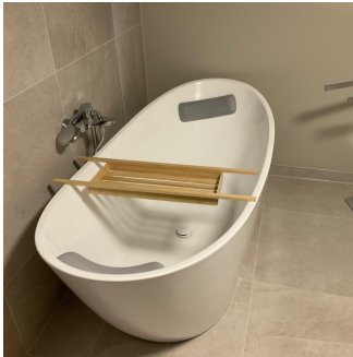
Frittstående badekar med avløp til sluk
