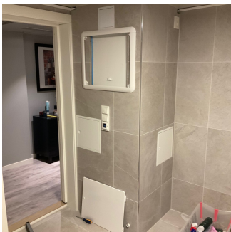
Tilgang til fordelerskap med stengeventiler
