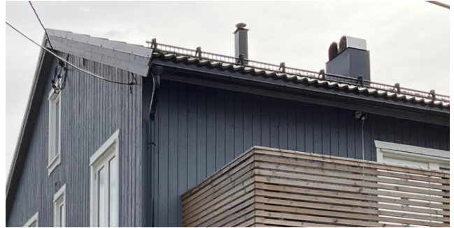
Boligen er utstyrt med snøfangere på hver side av taket
