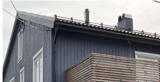
Boligen er utstyrt med snøfangere på hver side av taket
