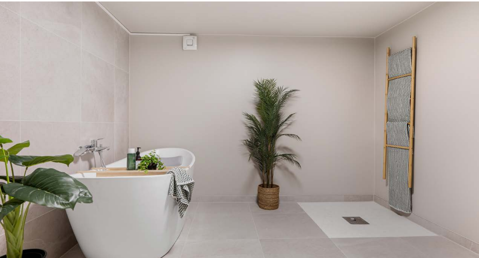
Badet er tilrettelagt for ekstra dusjsone med ferdig slukløsning og rørplegg på vegg.
