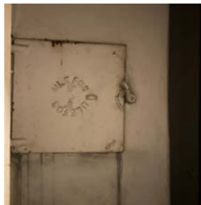
Feieluke på pipemur i kjeller, tilgang via deksel på innkassing ved nytt baderom.
