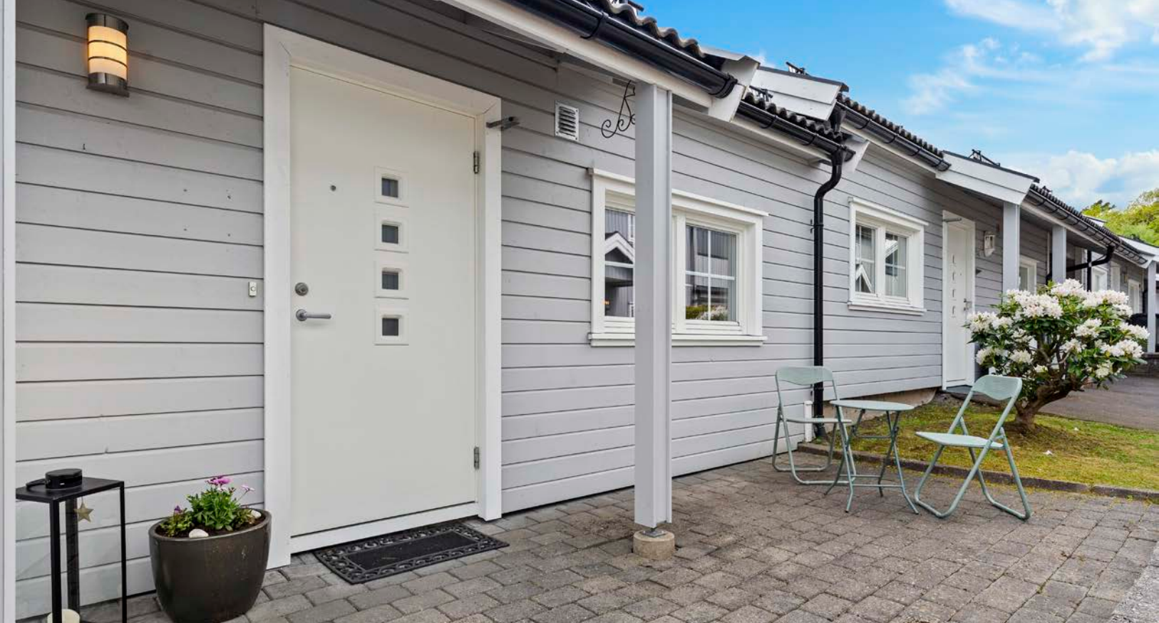
Hyggelig inngangsparti med terrasse av belegningsstein.
