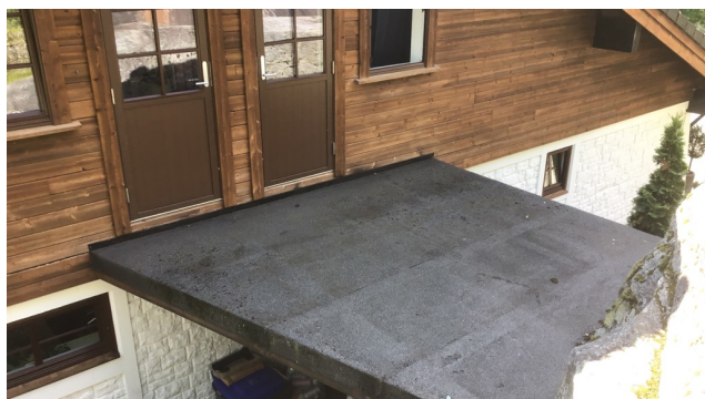
Mangler rekkverk/sikring
