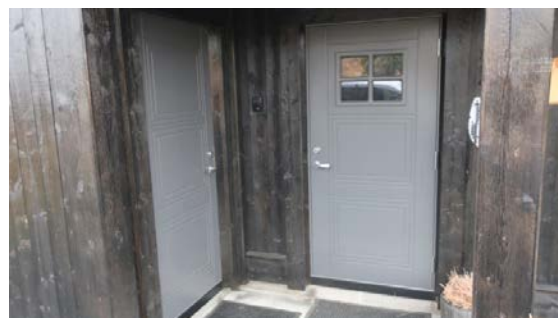
Hovedinngangsdør og dør til teknisk rom/bod
