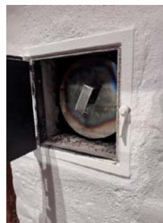
Synlig oppgradert pipeløp med innvendig foringsrør av stål.
