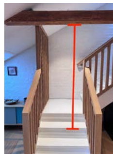
Lav høyde mellom trapp og bærende del av takkonstruksjonen.
