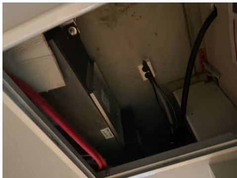
Luke i tak til ventilasjon
