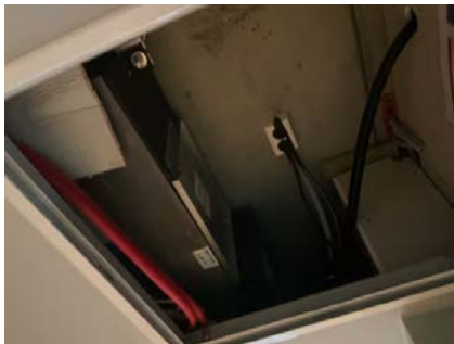
Luke i tak til ventilasjon
