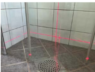
Fall på baderomsgulv er kontrollert med krysslaser.
