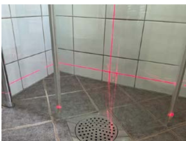
Fall på baderomsgulv er kontrollert med krysslaser.
