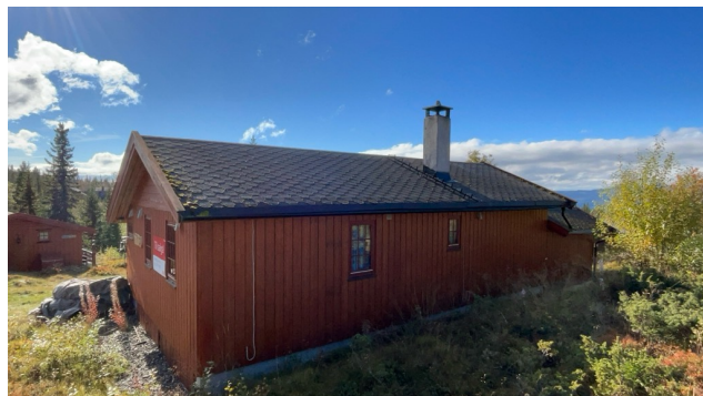
Besiktigelse av taktekke.
