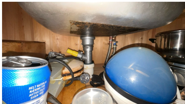
Besiktigelse av rørøpplagg.
