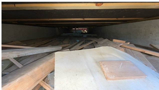
Besiktigelse av kryprom.
