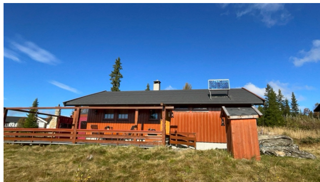
Besiktigelse av taktekke.
