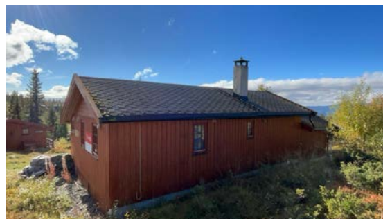
Besiktigelse av taktekke.
