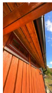
Synlige luftespalter i gesimskasse.
