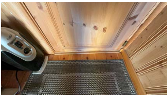
Luftespalte på dørblad bør opparbeides.
