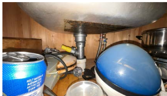
Besiktigelse av rørøpplagg.
