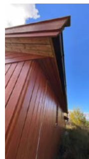
Synlige luftespalter i gesimskasse.
