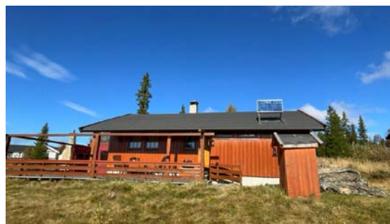
Besiktigelse av taktekke.
