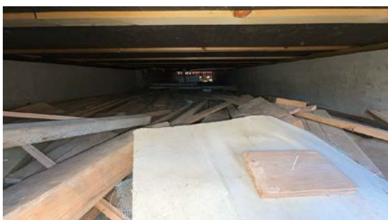
Besiktigelse av kryprom.
