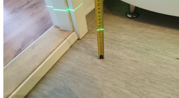
Kontroll av fall mot sluk.
