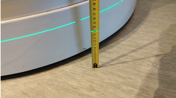
Kontroll av fall mot sluk.
