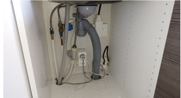
Kontroll av røropplegg.
