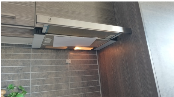
Funksjonstest av avtrekk.
