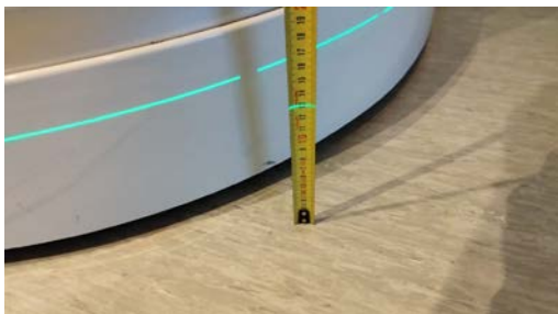
Kontroll av fall mot sluk.
