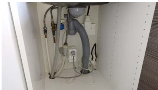
Kontroll av røropplegg.
