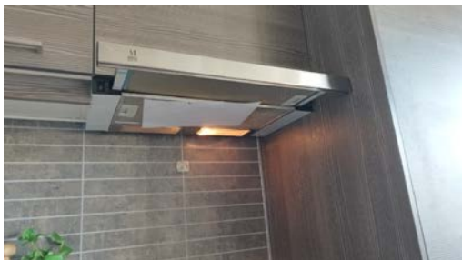
Funksjonstest av avtrekk.
