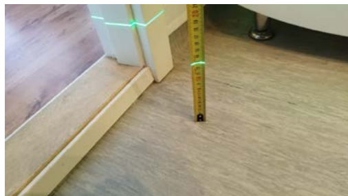
Kontroll av fall mot sluk.
