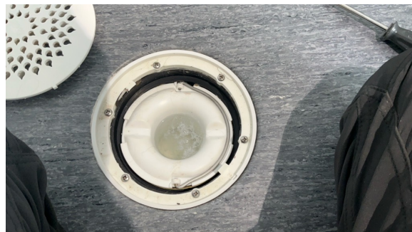
og Kontroll av sluk.
