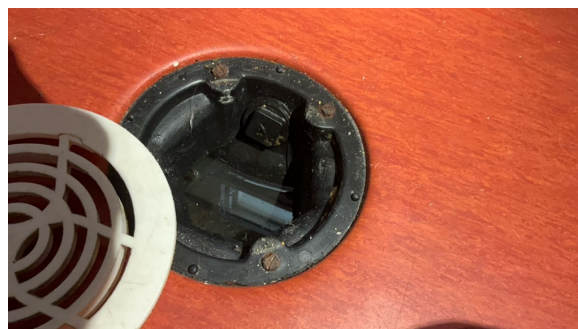
Kontroll av sluk.
