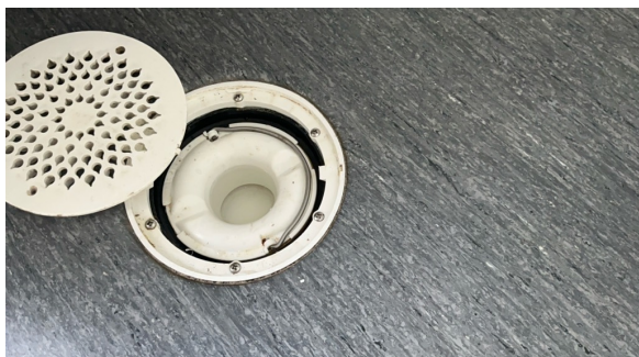
Kontroll av sluk.
