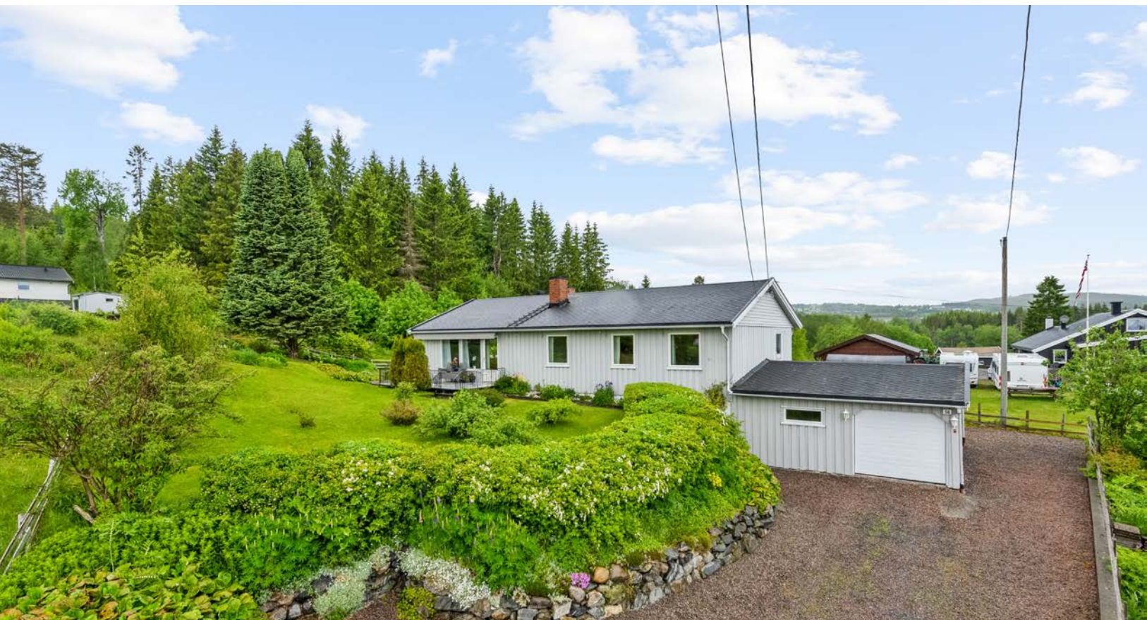
Garasje på eiendommen.
