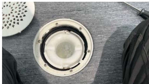
og Kontroll av sluk.
