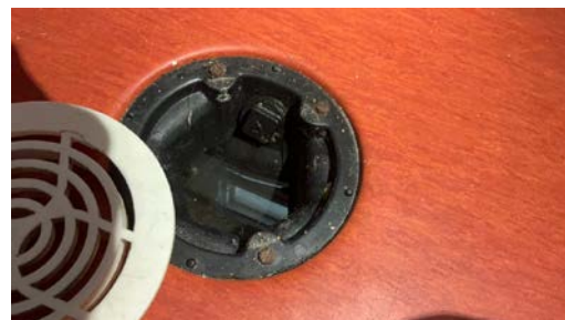
Kontroll av sluk.
