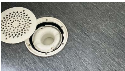
Kontroll av sluk.
