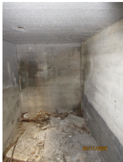
Kryprom under balkong mot sør-vest
