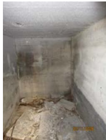
Kryprom under balkong mot sør-vest
