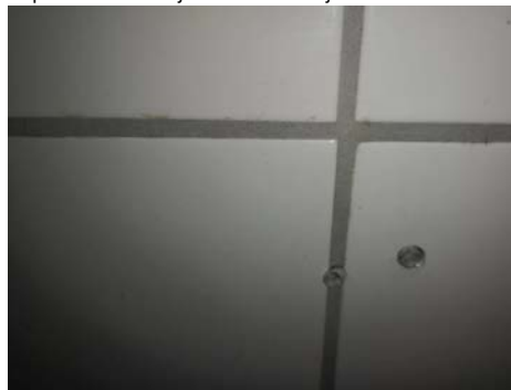
Hull som punkterer tettesjiktet i konstruksjonen.
