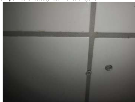
Hull som punkterer tettesjiktet i konstruksjonen.
