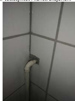
Hull som punkterer tettesjiktet i konstruksjonen.
