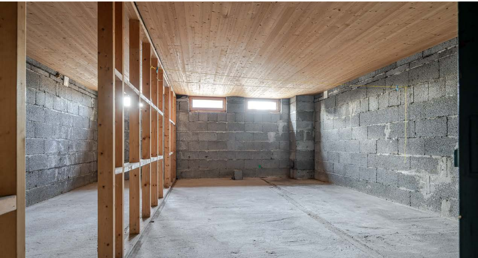
Kjeller på totalt 85m 2 som består av flere kjellerrom, eldre bad og toalettrom.
