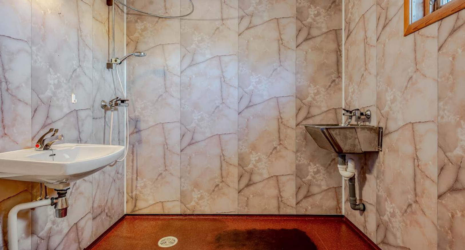
Baderommet har våtromsbelegg på gulv, elektriske varmekabler og våtromsplater på veggene.
