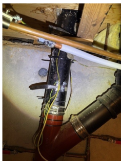
Plastrør med overgang til eldre soilrør i bygget.
