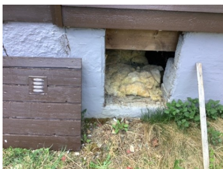
Luke til krypekjeller utvendig. Under toalett og bod.
