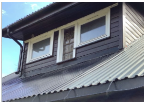
Vindu/glassbyggerstein er blendet på innside.
