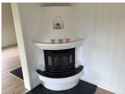
Det er brennbart materiale for nærme pipevange.
