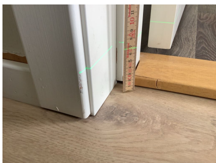
Gang loftetasje har høydeforskjell på 28mm.
