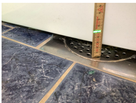
11 mm fall totalt til sluk.
