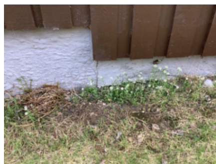
Det er ukjent om det er blindkjeller under tilbygget inngang.
