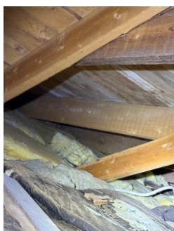
Isolasjon dekker luftespalte i skråtak.
