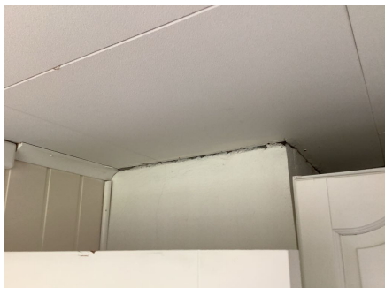
Det er brennbart materiale for nærme pipevange.
