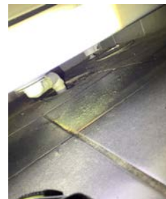
Sluk er plassert under kabinett.
