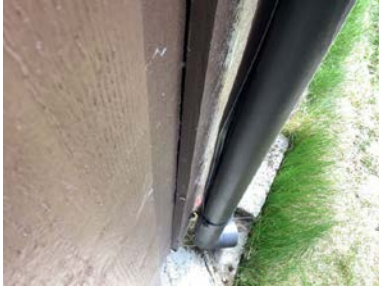
Frostsprengt nedløpsrør
