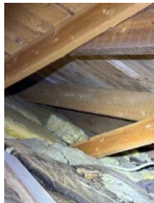
Isolasjon dekker luftespalte i skråtak.
