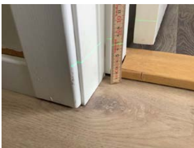
Gang loftetasje har høydeforskjell på 28mm.
