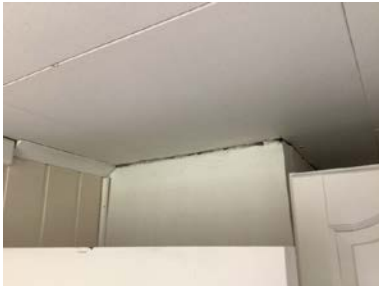
Det er brennbart materiale for nærme pipevange.
