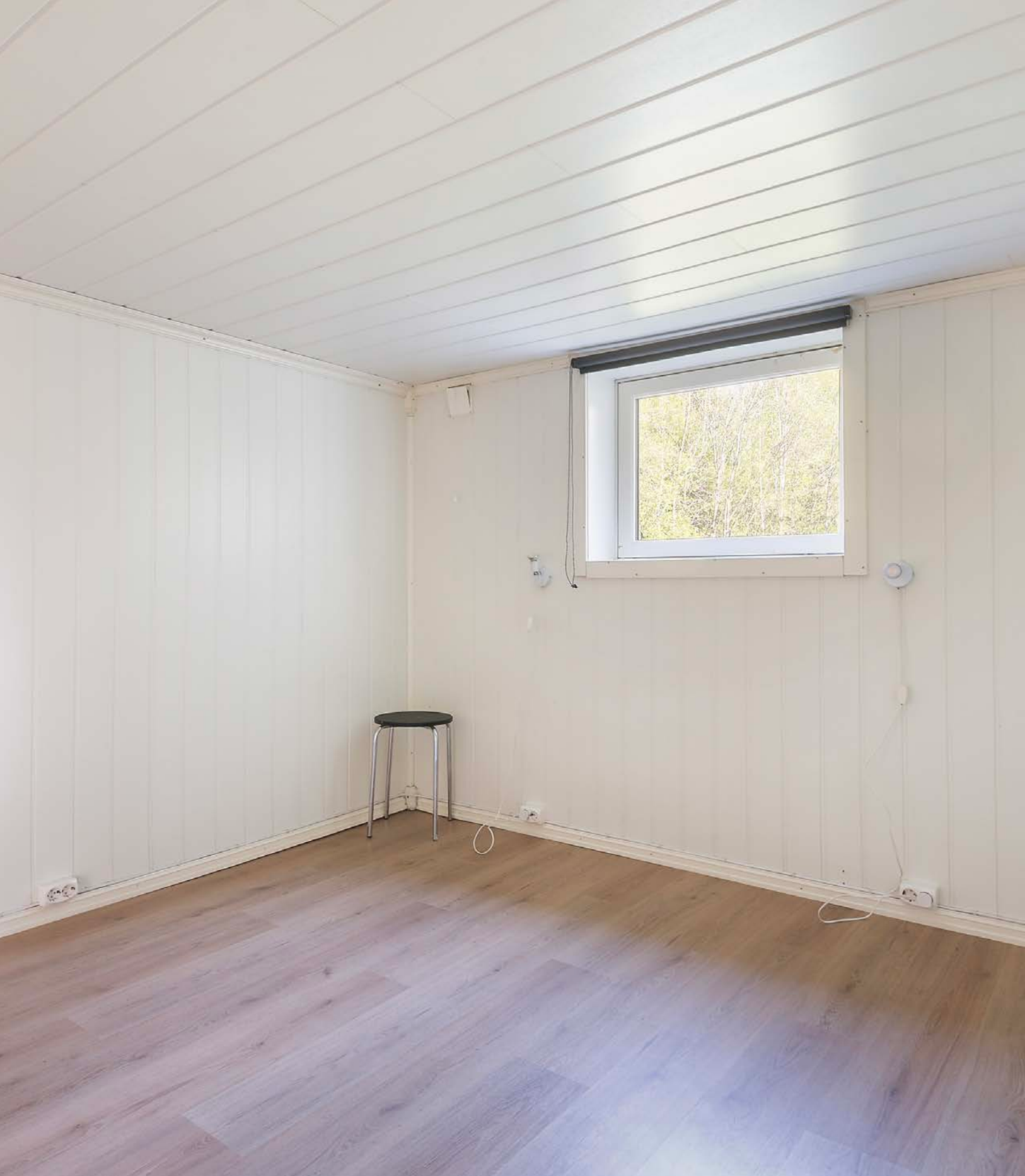
Kjellerrom ikke bruksendret.
