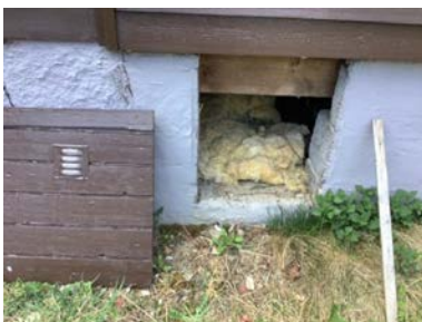
Luke til krypekjeller utvendig. Under toalett og bod.
