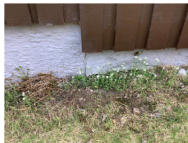
Det er ukjent om det er blindkjeller under tilbygget inngang.
