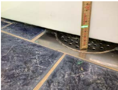
11 mm fall totalt til sluk.
