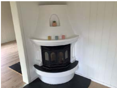
Det er brennbart materiale for nærme pipevange.
