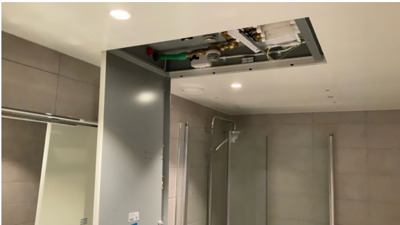
Rørøplegg i innvendig tak i bad.
