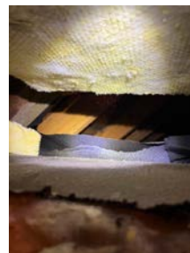
Inspeksjon gjennom luken i himlingen
