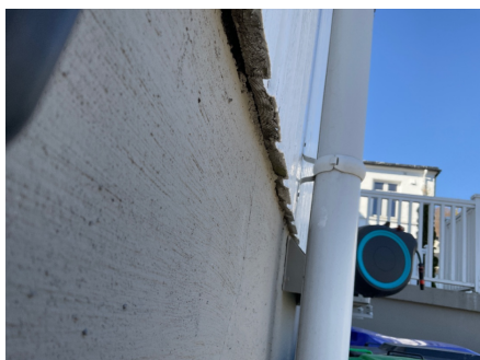
Kledning uten lufting.
