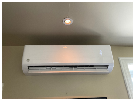
Luft til luft varmepumpe.
