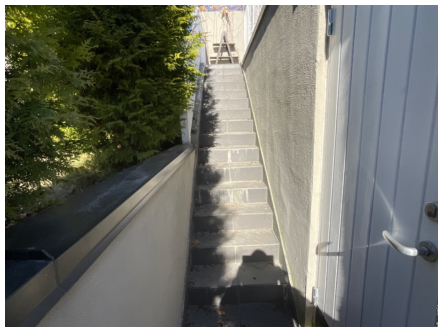
Trapp til takterrasse.
