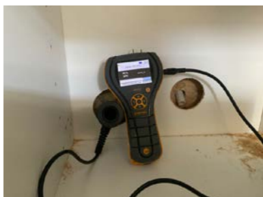
Fuktmåling i vegg ved hulltaking.
