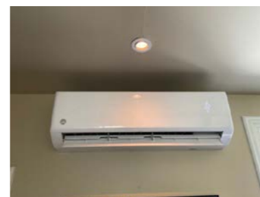
Luft til luft varmepumpe.
