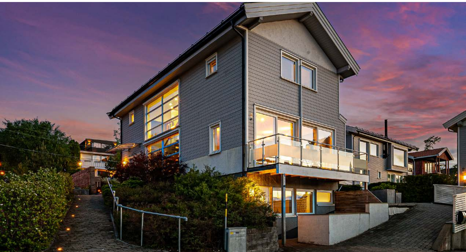
Sleppenvegen 1A har et lettstelt uteområde med steinlagt gangsti med varmekabel og nedfelt lys som leder vei til inngangspartiet. Boligens underetasje har egen inngang fra bakkeplan til stue og oppholdsrom.
