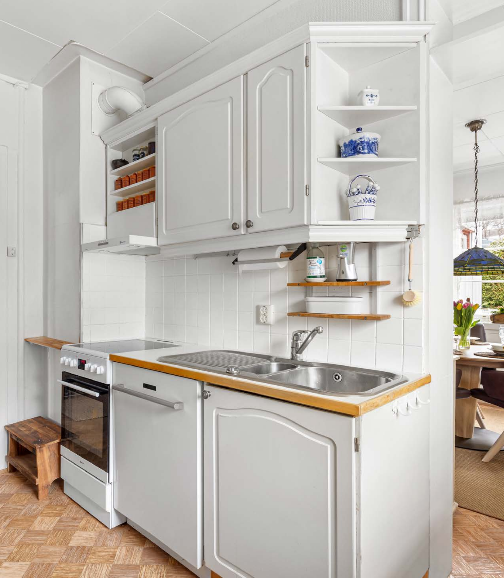
Heltre benkeplate og laminat benkeplate med nedfelt kum i rustfritt stål. Ventilator med avtrekk til pipeavtrekket
