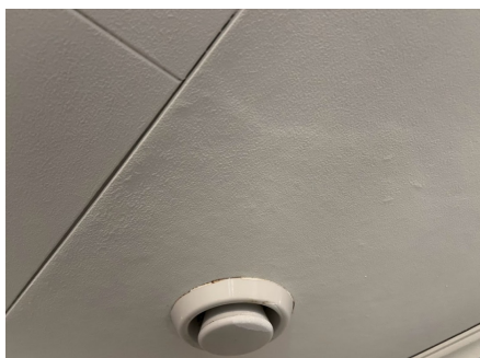
Fuktskadet takplate
